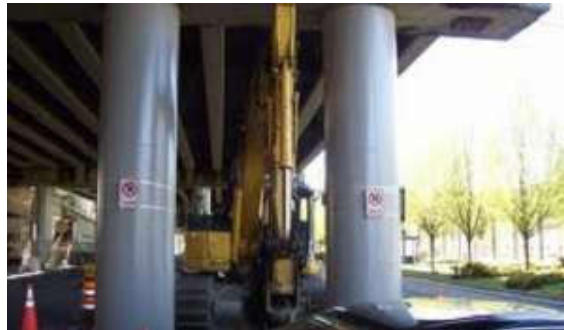
شکل 2: اجرای روکش ستون فولادی
