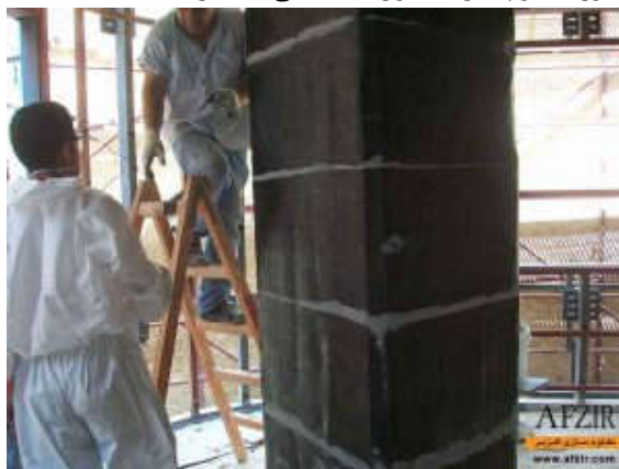
ترمیم ستون بتنی با الیاف FRP
