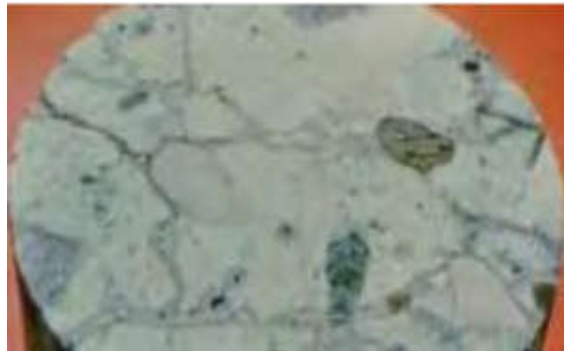
شکل (1): ترک های کشیده در اطراف سنگدانه ها
