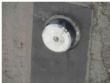
تصویر ج) نصب دستگاه Pull-off
