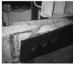
یک لایه ورقه یکپارچه CFRP و په صورت U شکل و یا جهت اصلی فیبر 90 درجه
