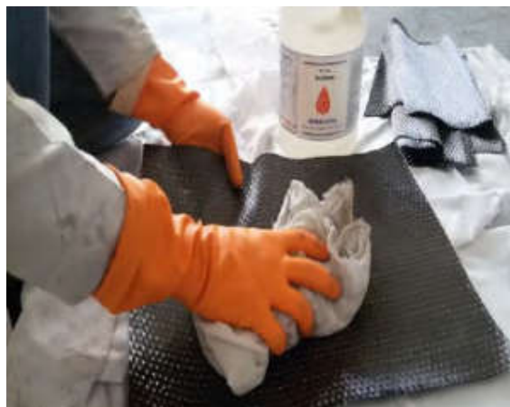
شکل (3) : تمیز کردن FRP با استفاده از استون
