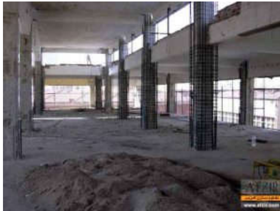
مقاوم سازی ستون بتنی به روش ژاکت بتنی
