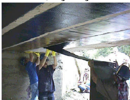
شکل 17- تقویت عرشه پل با ورقه FRP [12]
