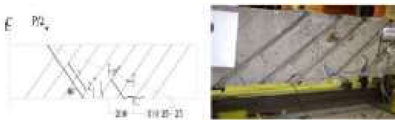
مکانیزم ترک‌های ایجاد شده-مقاوم-سازی
