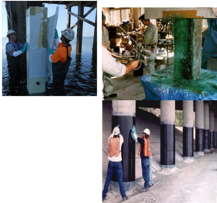
شکل (1) مقاومسازی ستون‌های بتنی با FRP: اسپری - محافظه‌ای - پوششی
