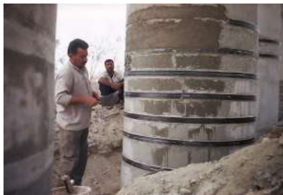
شکل 6: استفاده از لمینیت الیاف کربن در فرآیند مقاوم‌سازی پایه‌های پل‌های راه‌آهن محور بافق-بندرعباس a
