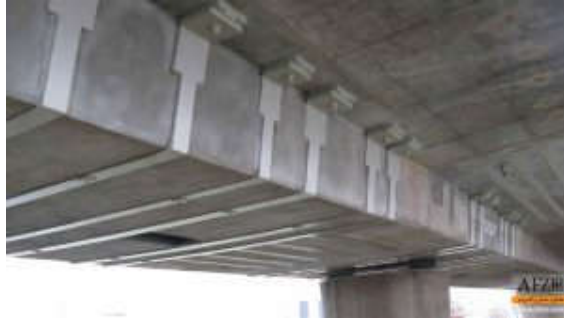
تقویت دال بتنی با ورق فولادی
