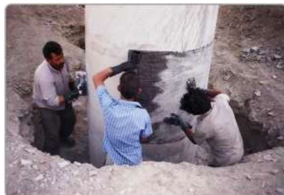
شکل 7: استفاده از شست الیاف کربن در فرآیند مقاوم‌سازی پایه‌های پل‌های راه‌آهن محور بافق-بندرعباس
