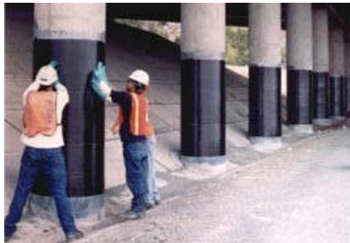
شکل 3: اجرای روکش تیر و ستون بتنی با مصالح FRP
