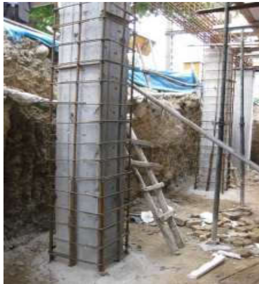
شکل 1: اجرای روکش ستون بتن مسلح
