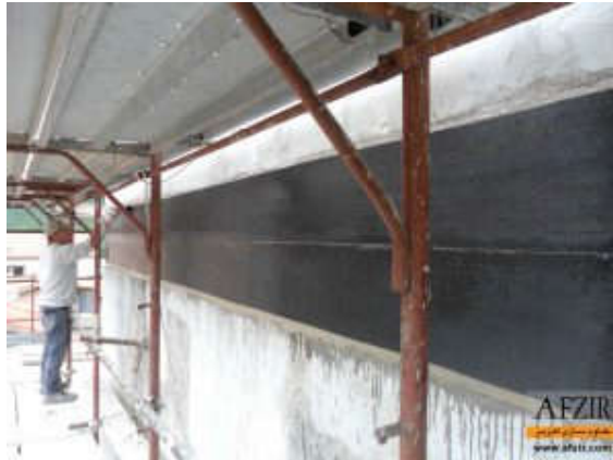
ترمیم دیوار بتنی با الیاف CFRP
