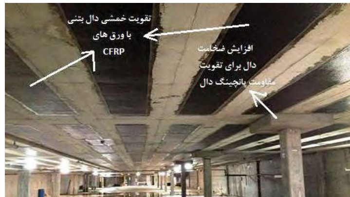
شکل 3: قسمت‌های تقویت‌شده‌ی دال بتنی با ورق‌های CFRP
